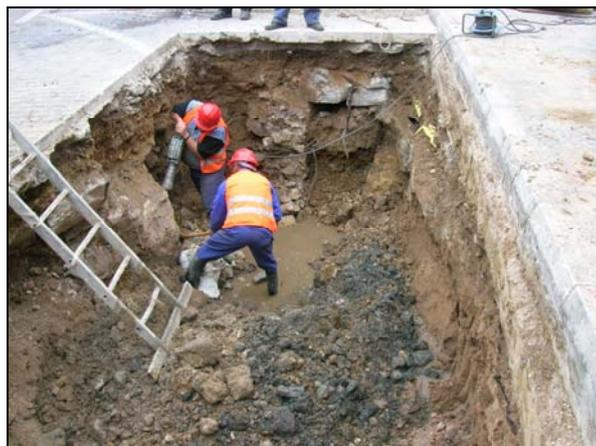
Fotografía de los trabajos para el soterramiento de contenedores.
